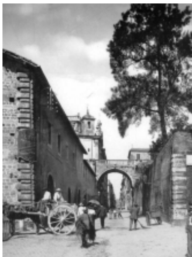
Palazzo Ruggia in via Giulia
